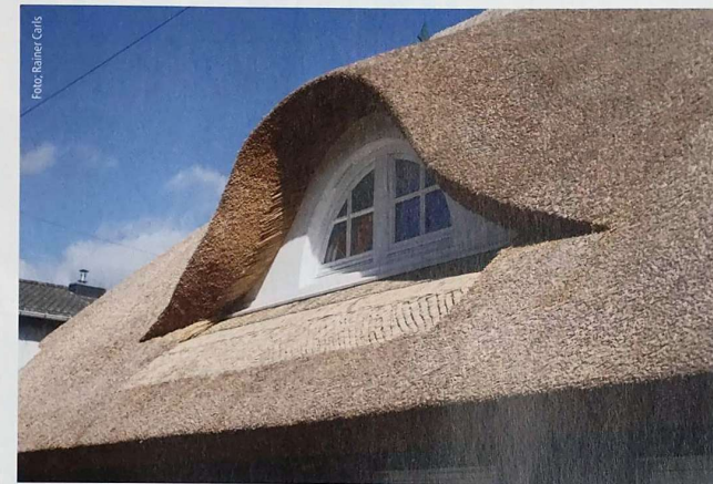
Die Fledermausgaube schmückt das Dach des Denkmalhauses in Greifswald/Wieck.
