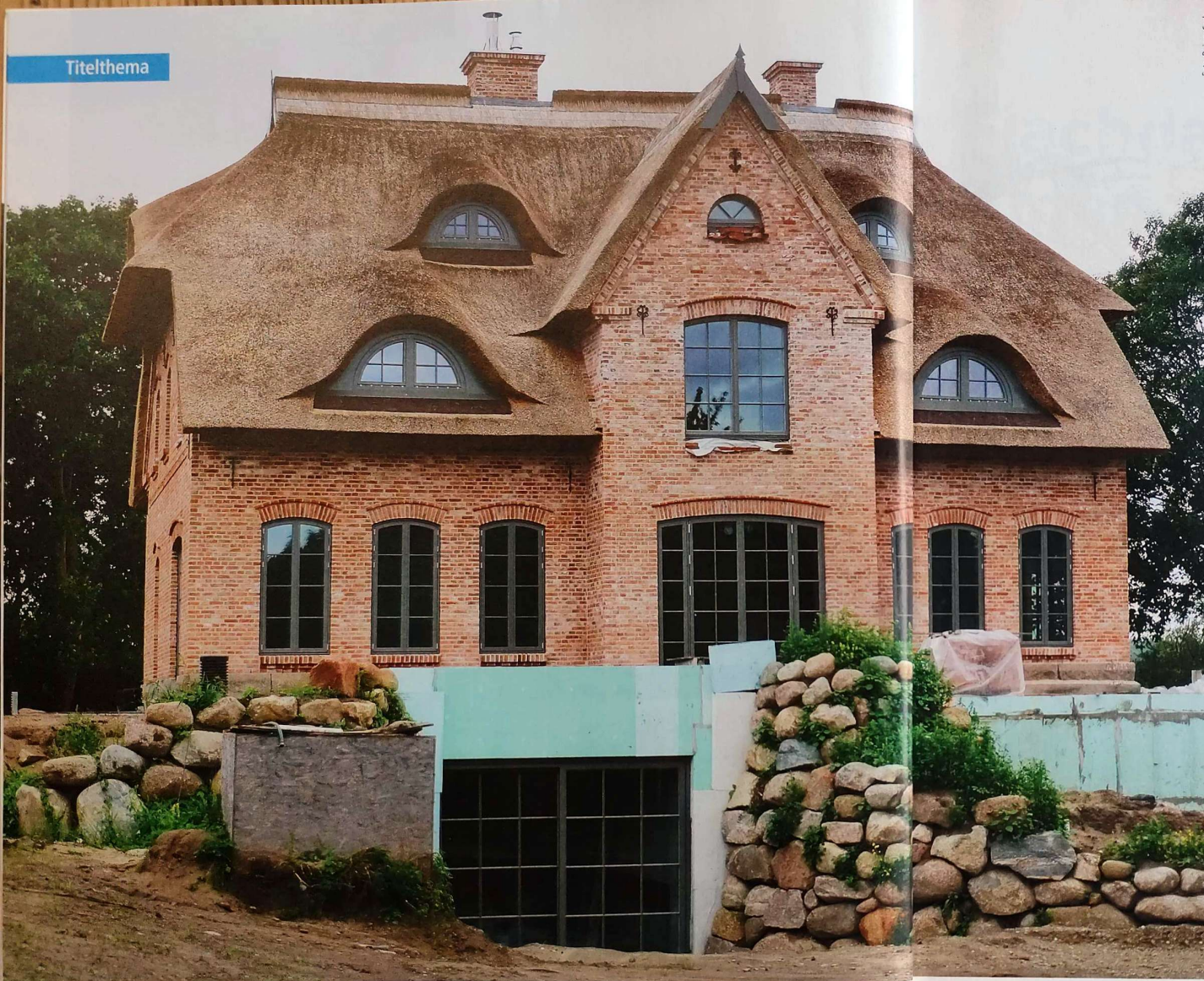
Die Fledermausgauben dieses Neubaus entstanden in gewerkeübergreifender Zusammenarbeit durch Steffen Paul und Rainer Carls.
