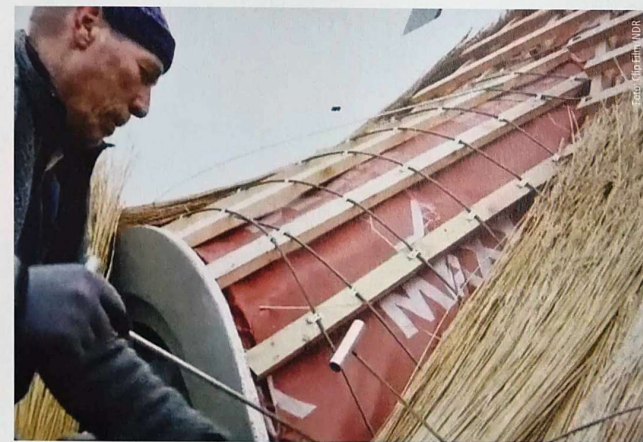
Die Verlegetechnik auf der Gaube unterscheidet sich bei Reet nicht von der vom Hauptdach, dauert aber naturgemäß etwas länger.
