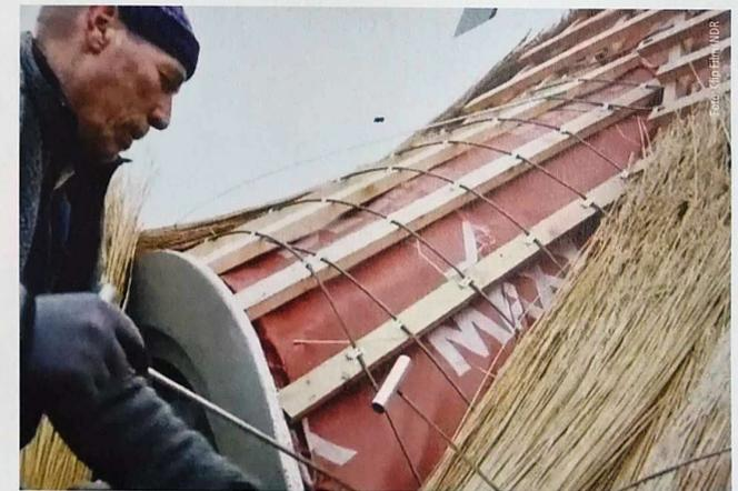
Die Verlegetechnik auf der Gaube unterscheidet sich bei Reet nicht von der vom Hauptdach, dauert aber naturgemäß etwas länger.
